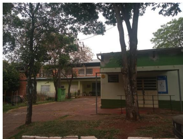
Figura 4. Vista do espaço físico externo do Posto de Saúde e Ginásio do Bairro Pindorama (sentido Sul-Norte), ano 2019.
