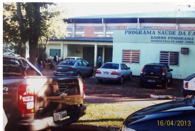
Figura 3. Vista do espaço físico externo do Posto de Saúde e Ginásio do Bairro Pindorama (sentido Sul-Norte), ano 2013.
