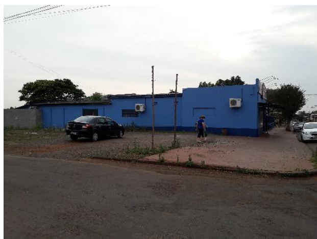
Figura 2. Vista do cruzamento entre as Ruas do Comércio e Universino Damaceno (sentido Leste-Oeste), ano 2019.
