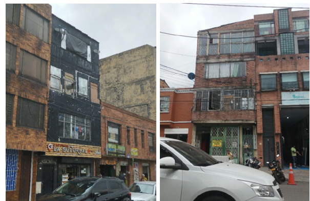
Figura 13. Predios en los que se realizan actividades industriales
