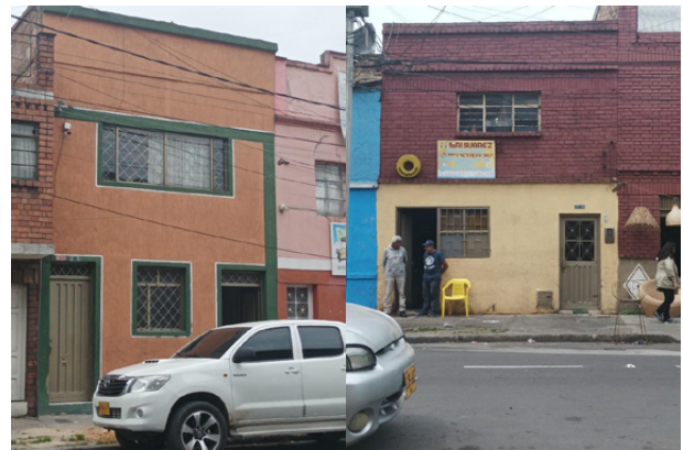
Figura 14. Predios en los que se realizan actividades industriales
