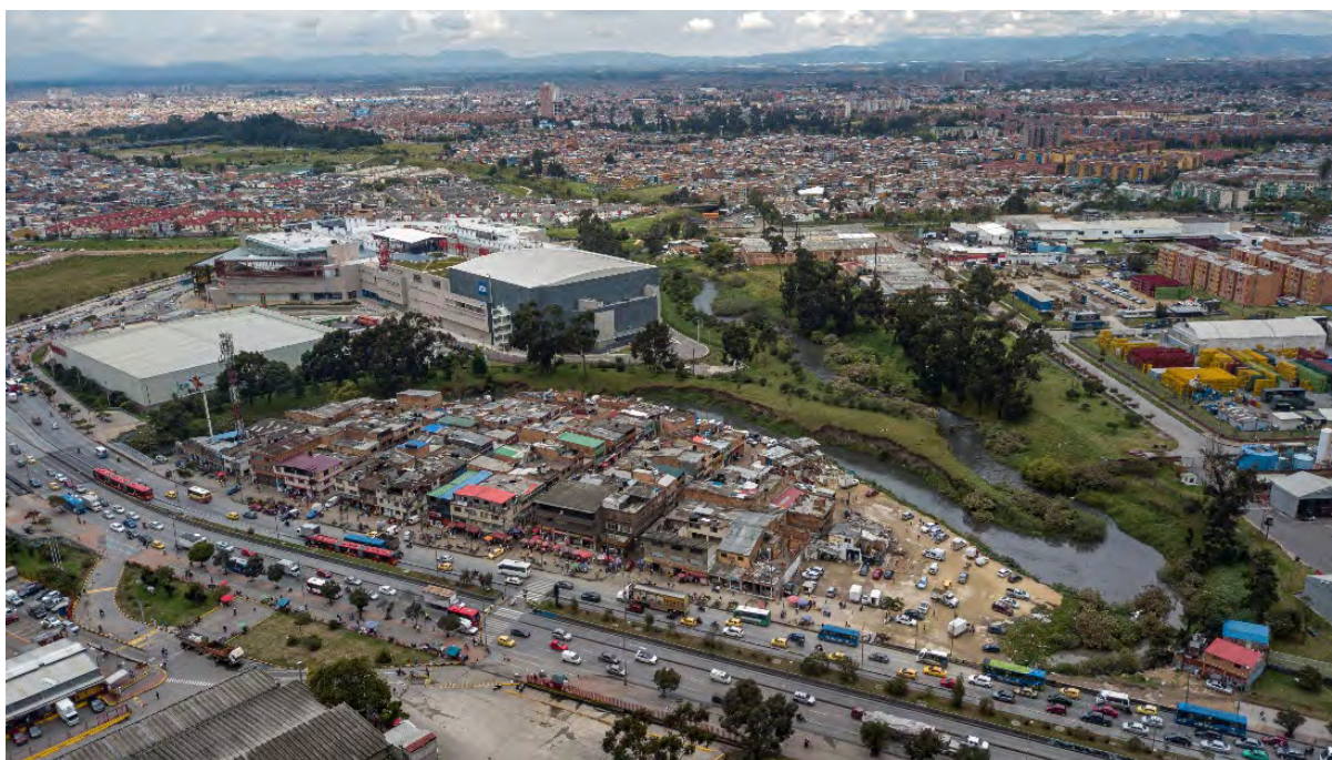
Figura 1. Vista aérea del barrio Guadalupe, anterior a su intervención en 2020
