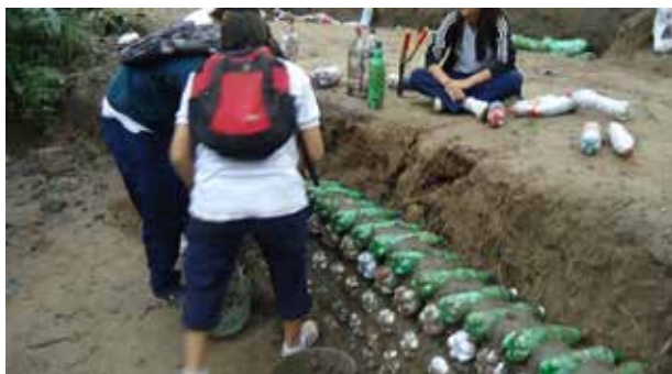
Figura 8. Elaboración de muro de contención con envase de gaseosa tamaño familiar (Foto: Arley Núñez)
