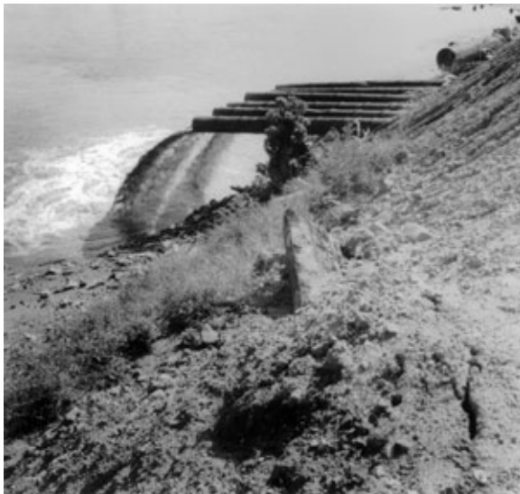
Fotografía 2. Monumento: Puente de bombeo (1967). Fotografía 3. Monumento: Fuente (1967).
